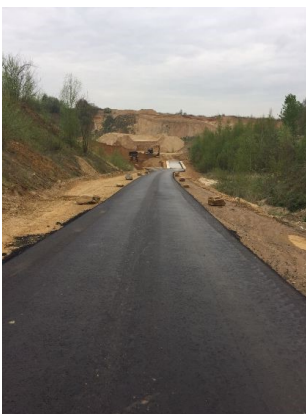
Nieuwe asfaltweg in de Groeve Spaubeek
